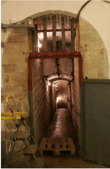
Travaux de sécurisation pour les portes ouvertes
