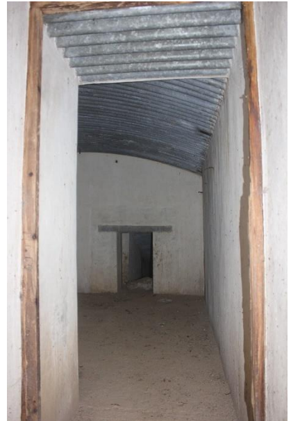
Vue de l'accès aux tranchées de protection
