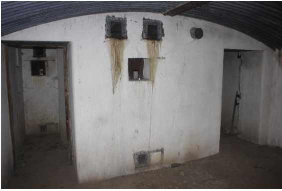
Vue intérieure de l'entrée du Blockhaus
