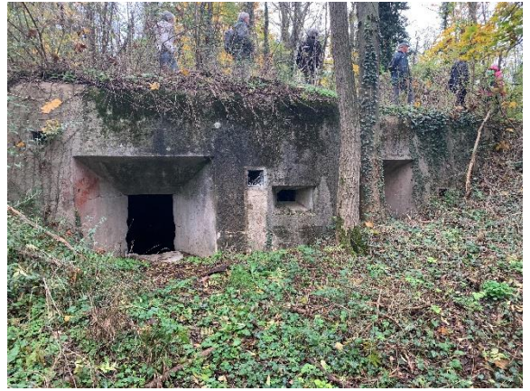
Batterie de flanquement Ouest: embrasure pour canon
