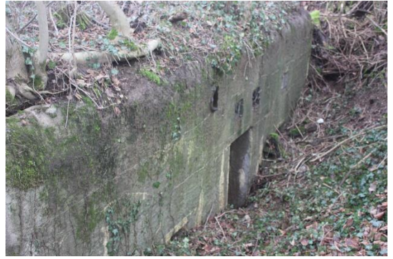
Vue de la façade
