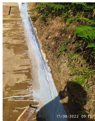
Dernière étape pour l'étanchéité
